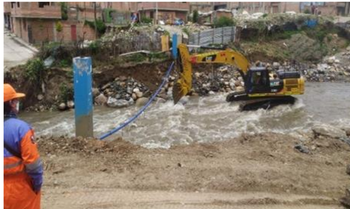
7. El 8.12.2021: Limpieza de lecho de río para facilitar trabajo de reparación de red secundaria de agua que abastece al barrio "Los Pinos", así como de los cimientos de las torres de suspensión (110 HDPE).
