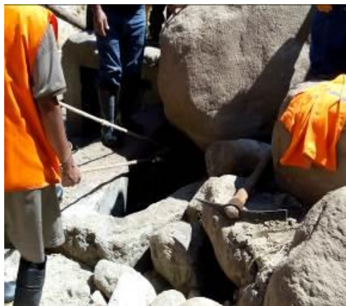
1. Trabajos de limpieza de la captación de la EPS CHAVÍN S.A..
