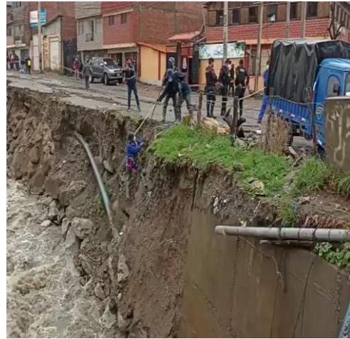
6. Taponeo en tubería de margen izquierda del río Quillcay para restablecer el servicio al sector de Ladislao Meza (8.12.2021)
